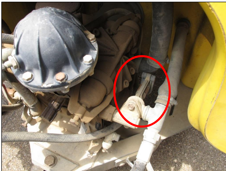
Compensatore di pressione collocato in prossimità del gruppo pompa e pertanto inadeguato.
